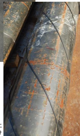
ケーシングパイプにエンボスケーブルを巻付け
